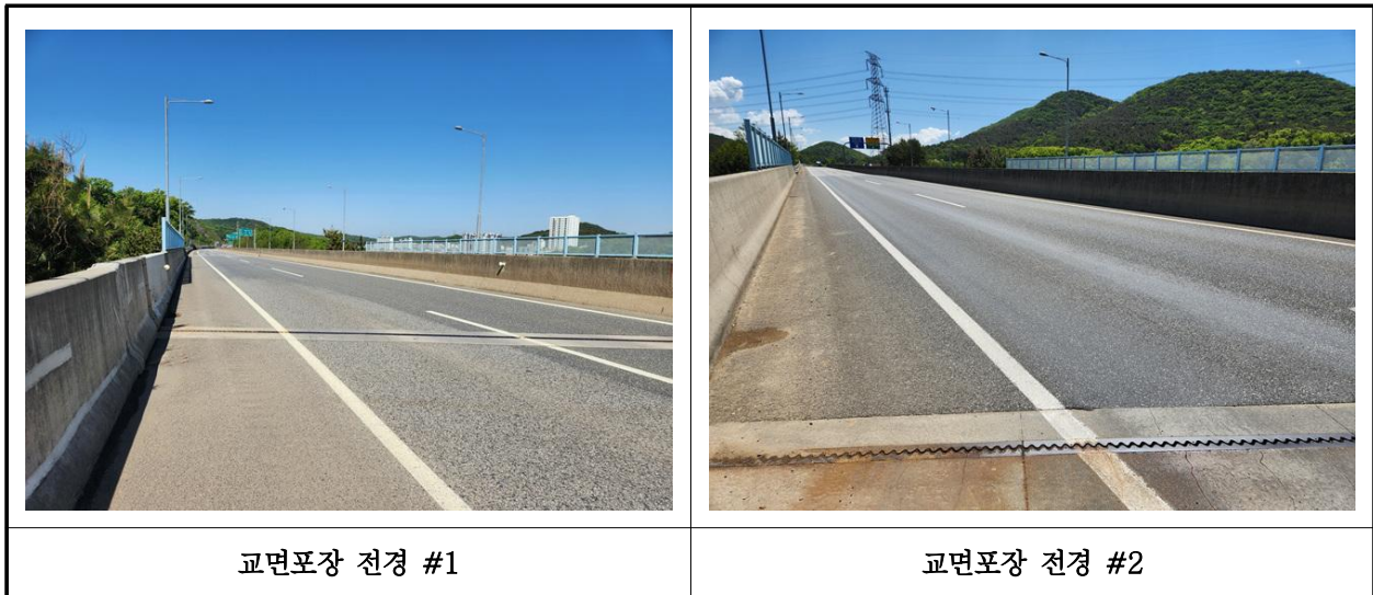
【사진 4.3.19】 교면포장 전경
