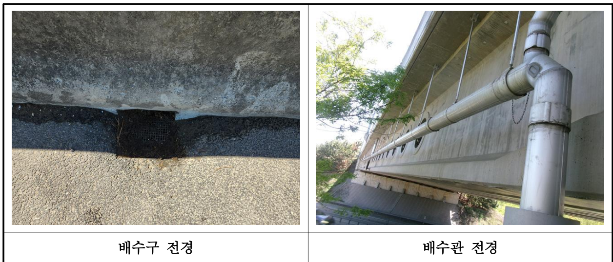
【사진 4.3.21】 배수시설 전경
