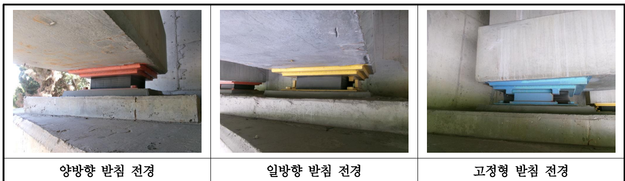
【사진 4.3.12】 교량받침 전경
