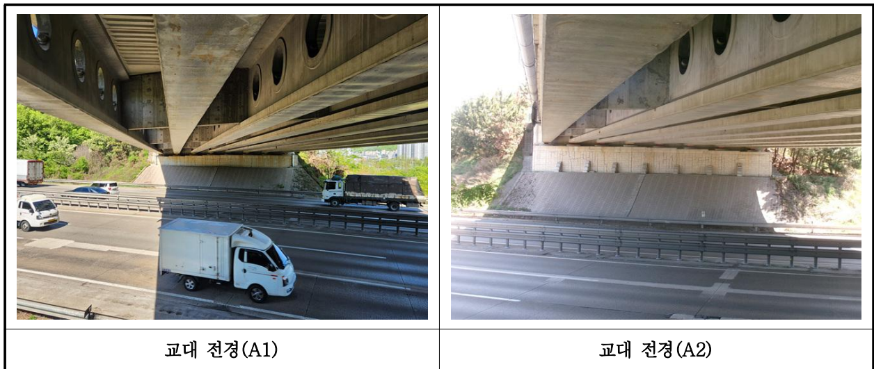
【사진 4.3.8】 교대 전경
