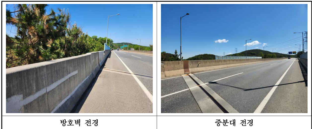
【사진 4.3.23】 방호벽 및 중분대 전경
