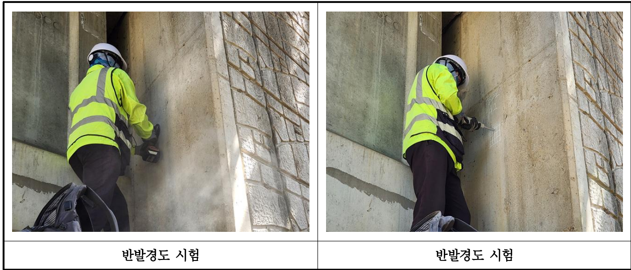
【사진 4.4.2】 반발경도시험 현장사진
