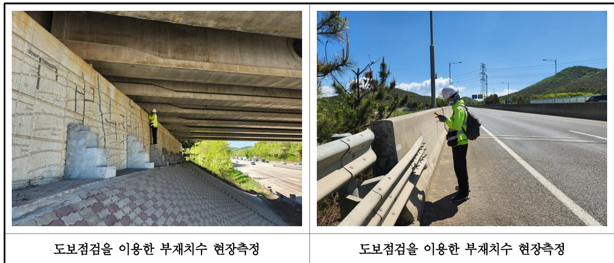
【사진 4.2.2】 부재 현장측정 전경
