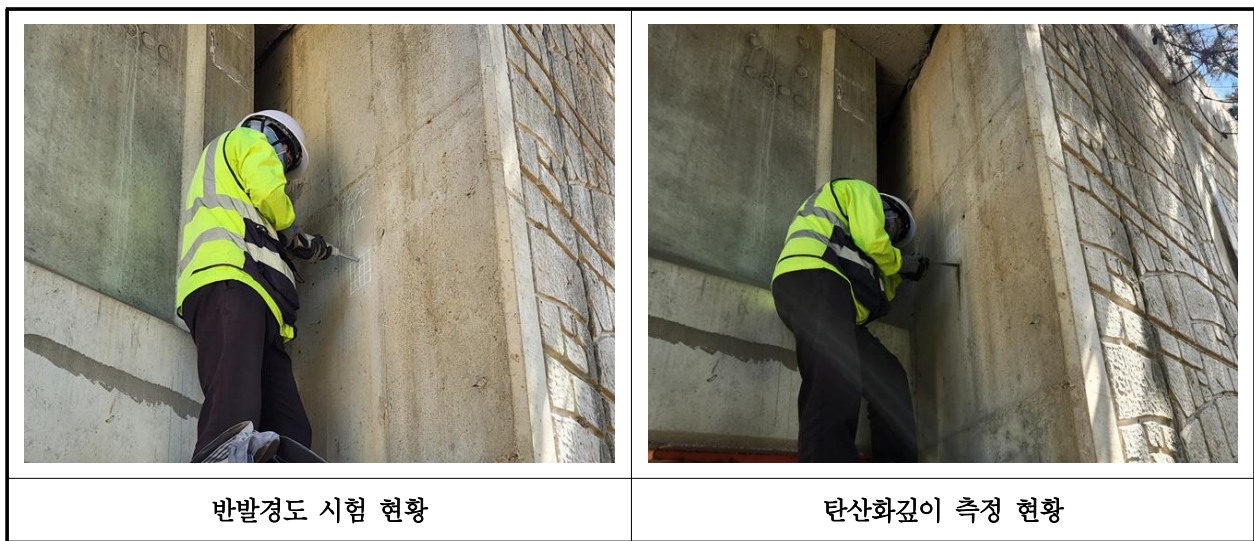
【사진 4.4.1】 콘크리트 내구성조사 현황
