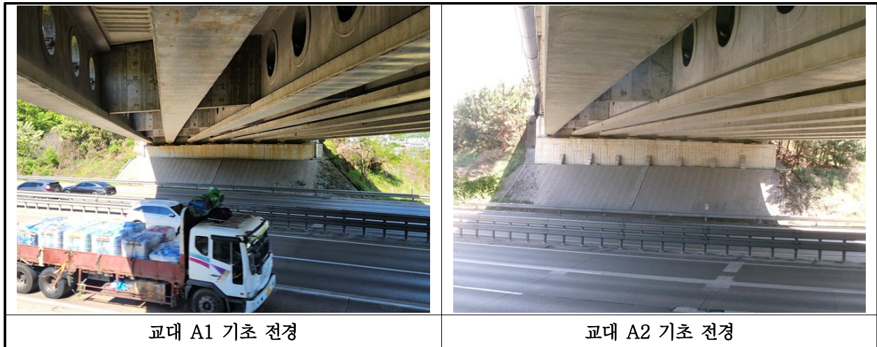
【사진 4.3.11】 기초 전경
